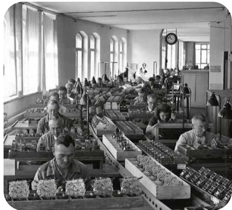
Montageabteilung für Halbstund- und Westminster Schlagwerke, Betriebsaufnahme der Firma Mauthe in Schwenningen, um 1950
